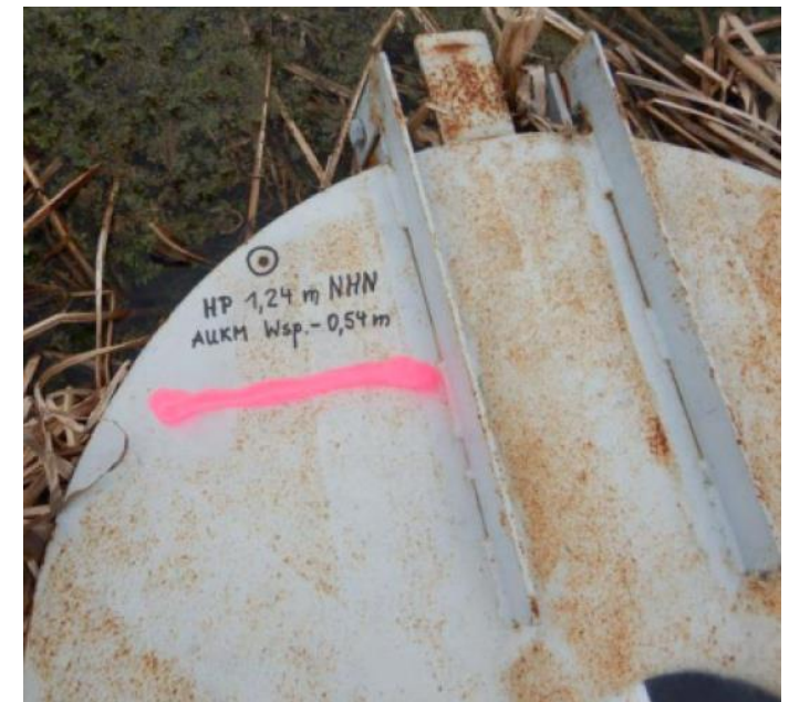
Staubauwerk mit Kontrollmarke
